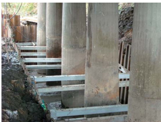
橋梁基礎補強工事
