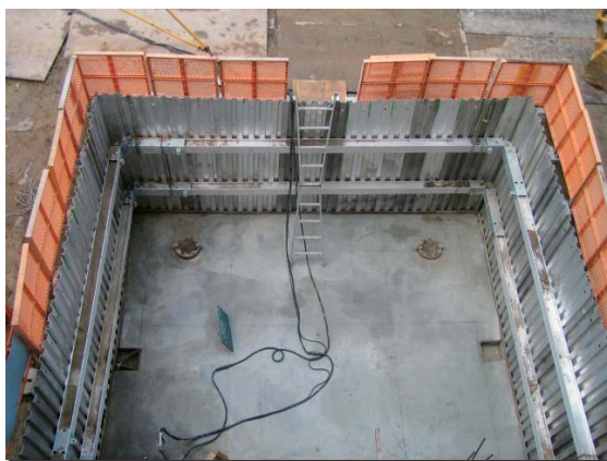
エレベーター基礎工事
