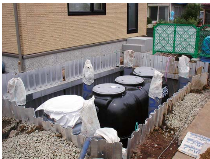
浄化槽設置工事[排水ポンプ付]
